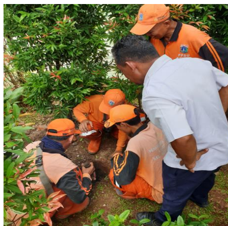
Gambar 4. Pembuatan lubang Biopori
