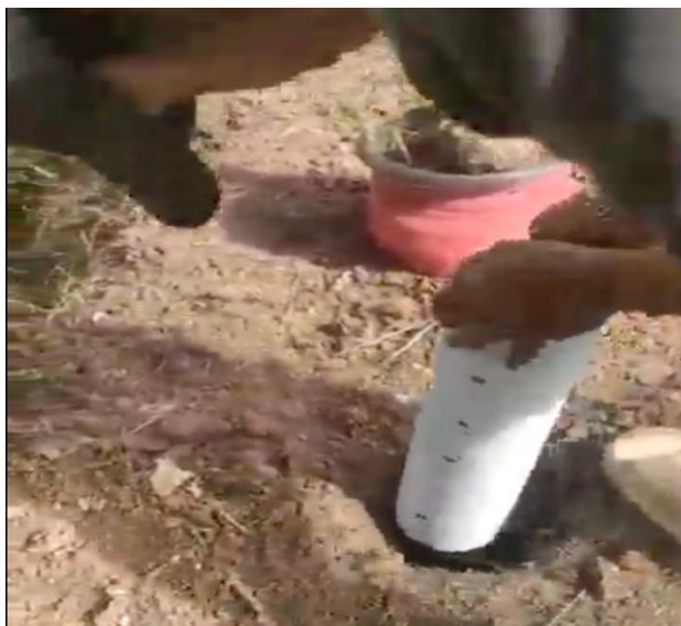
Gambar 4. Kegiatan pembuatan lubang Biopori dan pemanfaatannya
