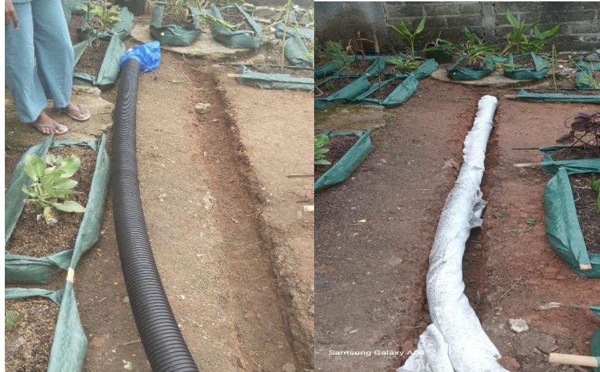
Gambar 6. Proses pembuatan drainase sederhana
